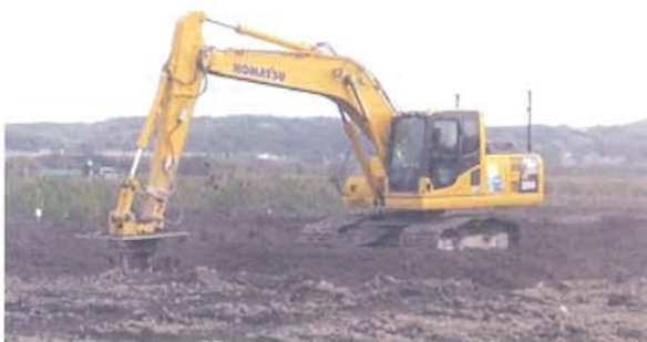
写真-5 地盤改良状況(表層)
