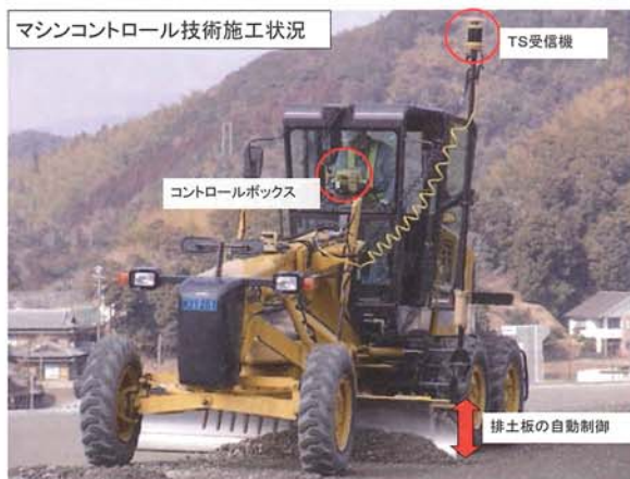
写真-2 MCグレーダによる施工 (ICT舗装工)
