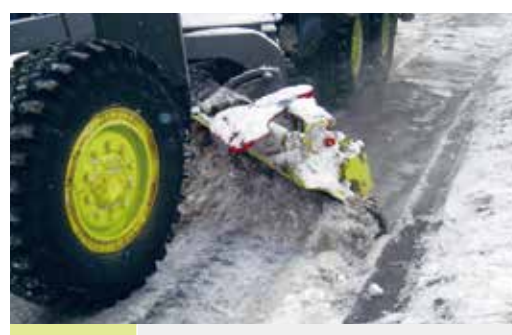
路面整正 ガタガタ・ポコポコになった路面を平らにします
