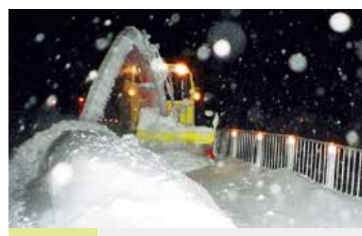
歩道除雪 通勤・通学時間前までに歩道の除雪を終わらせます
