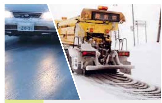
凍結防止剤 防滑材散布 すべりやすい路面に凍結防止剤や防滑剤を撒きすべりにくくします
