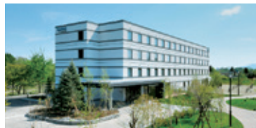
(仮称) NTB2北海道恵庭新築工事
