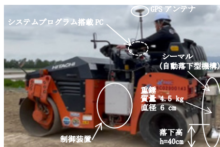
図-5 ローラーの装着状況
