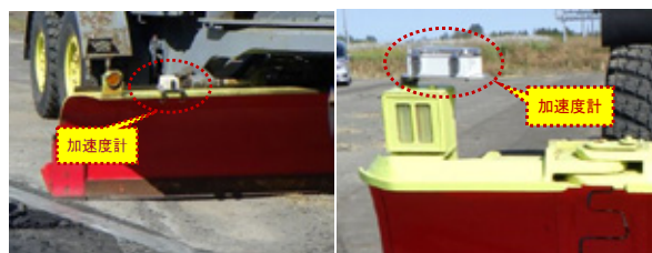
図-8 加速度計設置箇所 (左：除雪グレーダ、右：除雪ドーザ)
