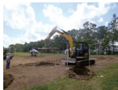
第2種(ショベル系建設機械)試験状況
