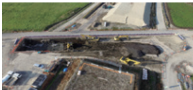
道央圏連絡道路 江別市 南5線道路改良工事
